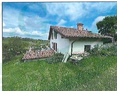
Foto 5 – Retro fabbricato prospetto sud est
