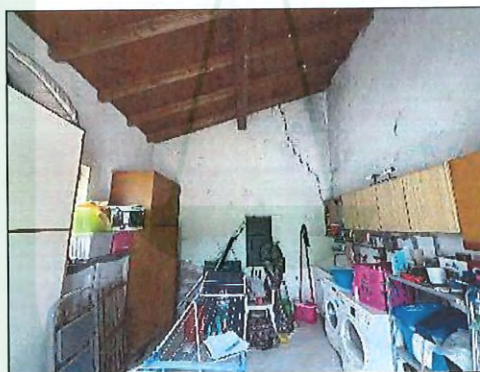
Foto 9 - Unità sub 1 locale lavanderia - deposito
